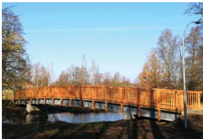
Brücke in der Trift-Verlängerung, Foto: Hans-Jürgen Strübing
